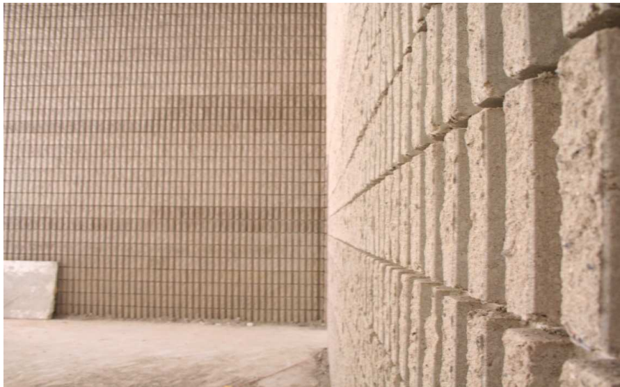
Digitürk ana stüdyo fugalı Yapıblok uygulaması
