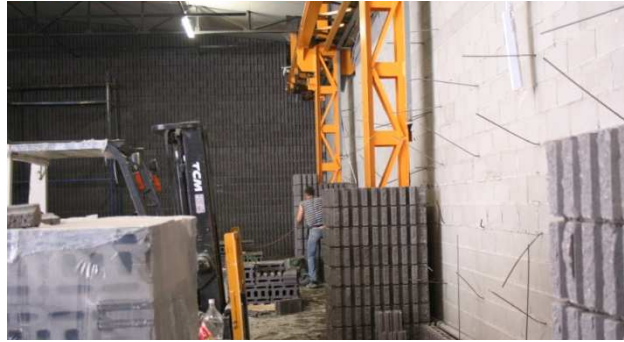
Çelik kolonlar ses yalıtımı için fugalı Yapıblok® ile kaplanmıştır.
